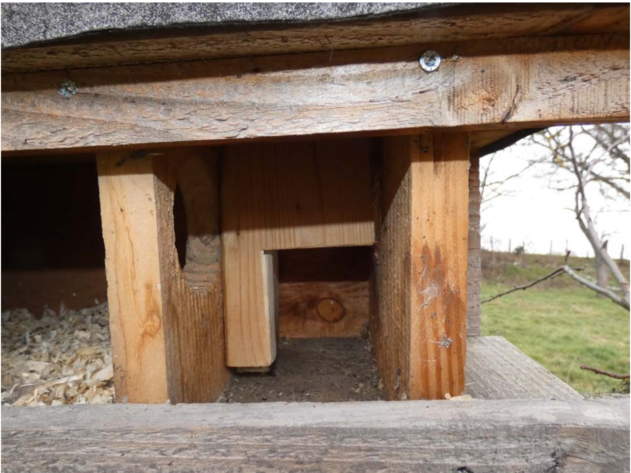
Abbildung 4: nachträglich im Frühjahr 2021 mit einem Zwischenbrett angebrachter Marderschutz
