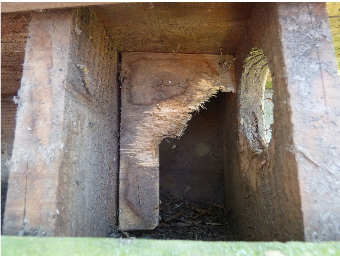
Abbildung 3: angefressener Marderschutz
