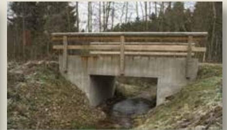
Si une voie de service traverse un ruisseau, on a souvent recours à un pont « en forme de casque » en acier et béton.
