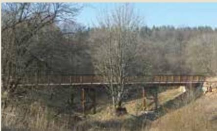
Sur le Helingsbach, digue et canalisations ont été retirées, puis un pont en bois a été construit pour les randonneurs, les cyclistes, les cavaliers et les véhicules des secours.
