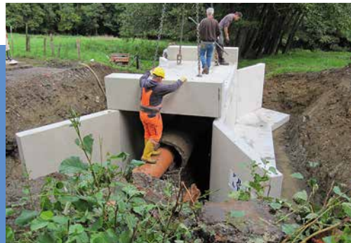
Bau der Brücke am Klafterbach, August 2014: Die Verrohrung wird erst später entfernt und dient so während der Bauphase noch der Wasserhaltung.
