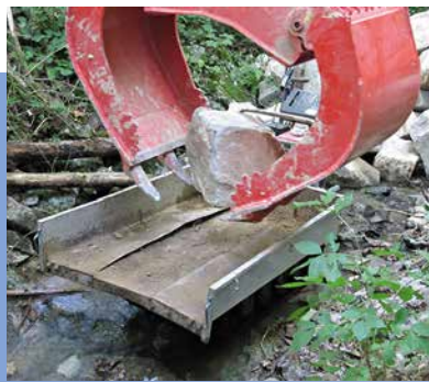
Das Einbringen von Steinriegeln in den Durchlass ist aufgrund der Länge (55m) und Enge im Durchlass nur mit handgeführten Kettendumpfern möglich.
