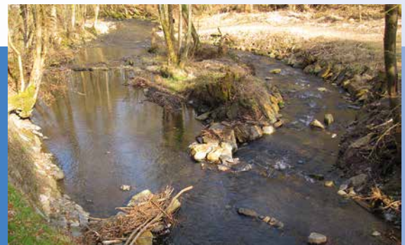
Blick stromaufwärts: Durch die höhere Lockströmung werden die Fische nicht mehr Richtung Wehr (rechts), sondern in die neu angelegte Flussschleife (links) geleitet.
