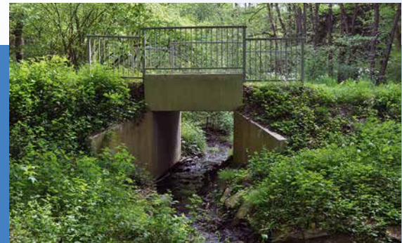
Die fertige Brücke am Bosselbach (etwa ein Jahr nach dem Bau): eine natürliche Bachsohle ohne Abstürze ermöglicht Fischen und Kleinlebewesen eine freie Wanderung auch im Bereich des Brückenbauwerks.
