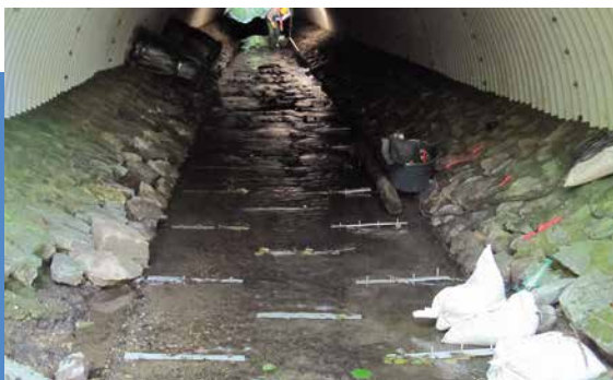
Um eine Ablagerung von Sohlsubstrat zu erleichtern, wurde ein Vlies auf die Betonsohle aufgedübelt. Innerhalb weniger Wochen füllten sich die überlappenden Vliestaschen mit Bachsediment.
