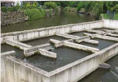
Fischauftiegsanlage in Roermond
